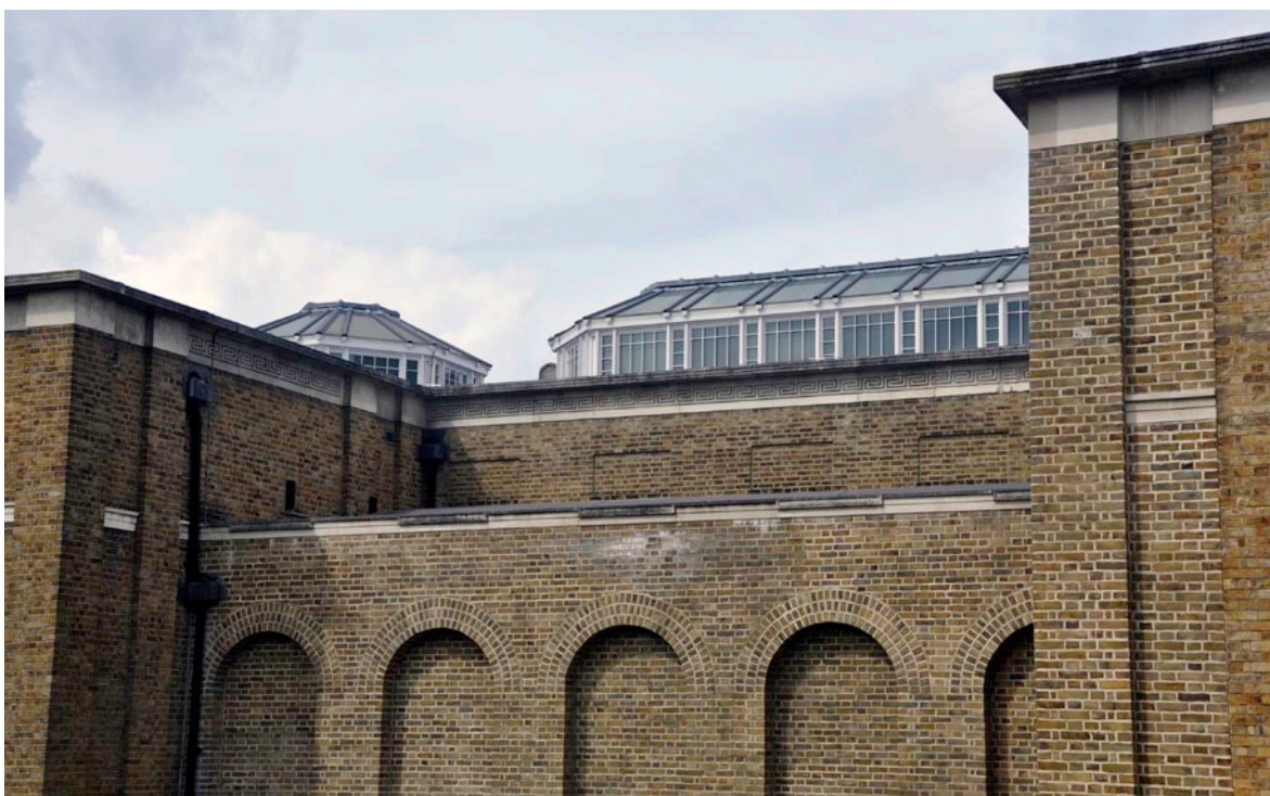
7. Świetliki dachowe i surowe detale ceglanej elewacji
